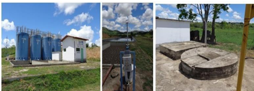
Figura 1. Estação de Tratamento de Esgoto à esquerda, queimador de gás inoperante no meio, e estação de Enleivamento de Esgoto à direita. Fonte: COPASA.
